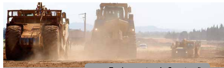
Equipamentos de Construção
