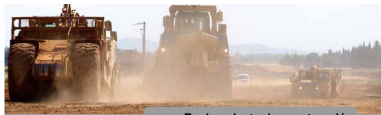
Equipamiento de construcción
